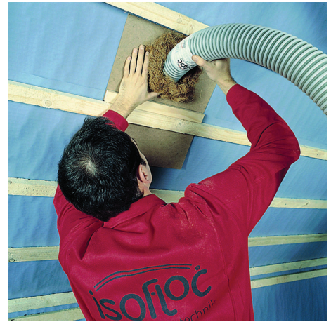
inblazen van isofloc cellulose isolatie in een hellend dak, via openingen in de damprem
