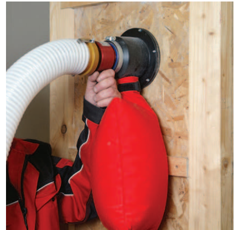
inblazen van isofloc cellulose in een houtskeletbouw wand met de speciale inblaaskop
