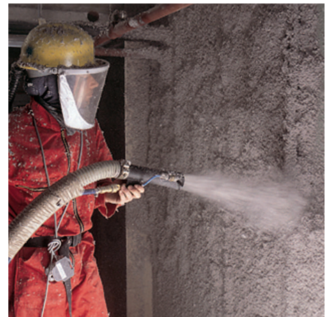
vochtig sproeien (CSO) van isofloc cellulose tegen een wand met de speciale sproeikop
