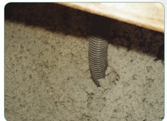
Aufblastechnik - die „professionelle“ Dämmung
