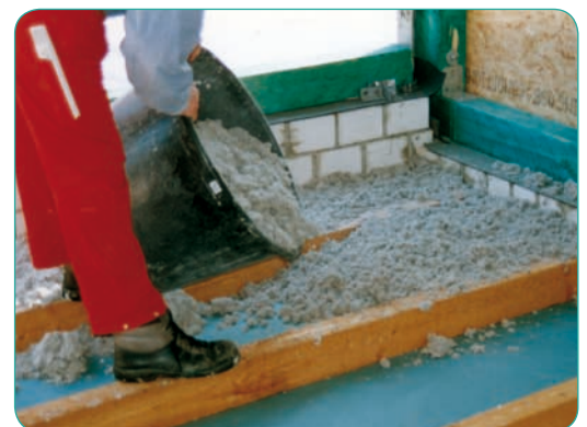
Dämmschüttung - die „einfache“ Dämmvariante
