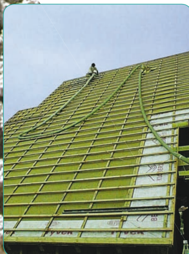
Dämmschüttung - die „einfache“ Dämmvariante
