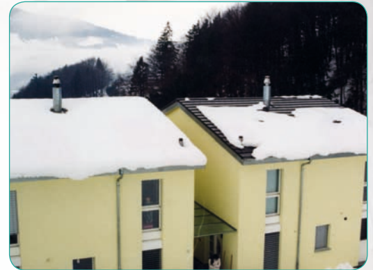
Linkes Dach: Dämmung mit unserem Zellulosedämmstoff
