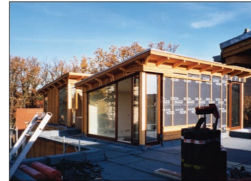
Das Dach als Leichtbaukonstruktion. Der Einsatz von wärmespeicherndem Zellulosedämmstoff schützt vor sommerlicher Überhitzung.
