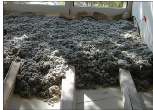
DÄMMSTATTs CI 040 im Deckenbereich offen aufgeblasen
