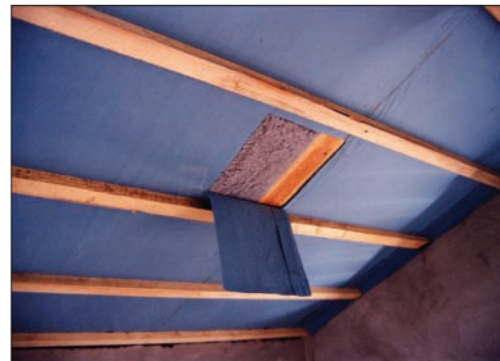
Der eingeblasene Zellulosedämmstoff füllt den Sparrenzwischenraum fugenlos aus.
