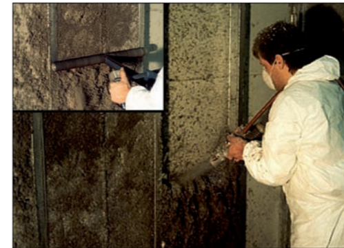
Aufsprühen der Zelluloseflocken im CSO-Verfahren und Abziehen der Oberfläche (kleines Bild)
