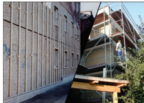
Dämmung einer Massivaußenwand mit DÄMMSTATTs CI 040
