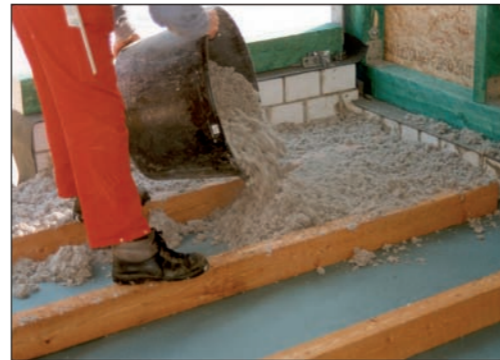
DÄMMSTATTs CI Dämmschüttung im Deckenbereich
