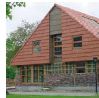
Ook bij laagenergiebouw opgetrokken in houtskelet wordt dikwijls geopteerd voor Celit in dak en wand. (Sint-Martens-Bodegem; arch. Bart Uvin)
