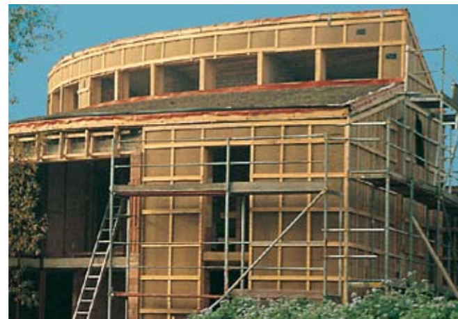
Tweegezinswoning: groen dak met 30 cm isolatie; muren in snelbouw met 16 cm isolatie + Celit 3D isolatiebeschermplaat
