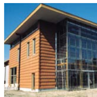
De isolatie tegen de dragende baksteen is afgedekt met de Celit 3D isolatiebeschermplaat; tegelpannen en lariksbeplanking als gevelbekleding. (Oxfam Wereldwinkels Gent; evr-Architecten)
